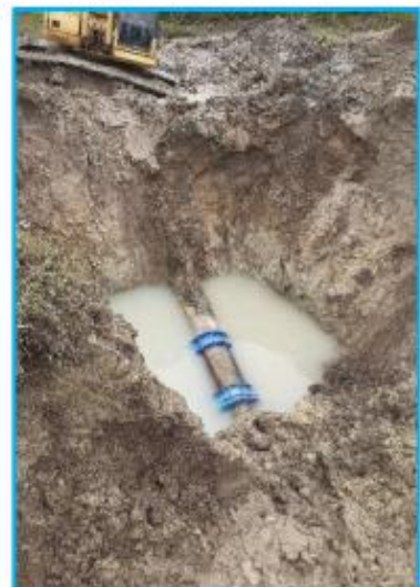
Verificación del estado de la reparación al siguiente día, comprobándose que se ha ejecutado a satisfacción.
