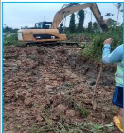
Excavación para descubrir el tubo de asbesto cemento de 800mm averiado.
