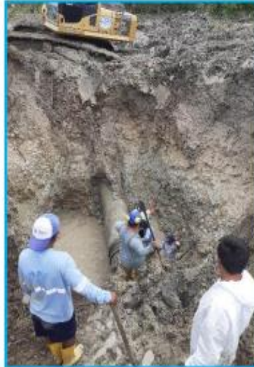
Descubrimiento manual del tubo de asbesto cemento de 700mm en el punto de la fuga.
