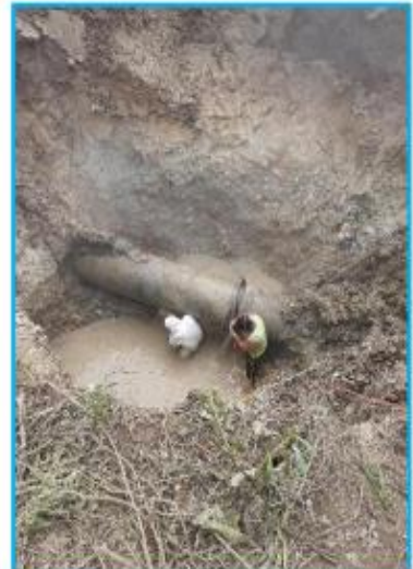
Corte con amoladora del tubo de asbesto cemento en el punto de la fuga.
