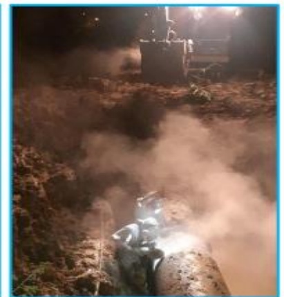
Corte con amoladora del tubo de asbesto cemento en el punto de la fuga.
