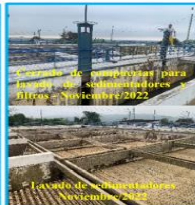
Limpieza y lavado de los floculadores de la planta de tratamiento de agua potable.
