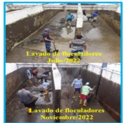
Limpieza y lavado de los floculadores de la planta de tratamiento de agua potable.
