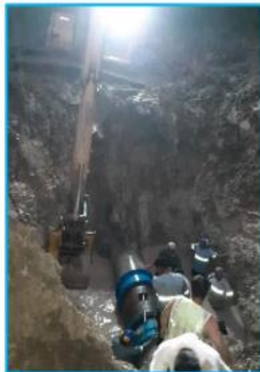
Cambio de tubería de asbesto cemento de 700mm, por hierro dúctil de 800mm; con uniones mecánicas asimétricas.
