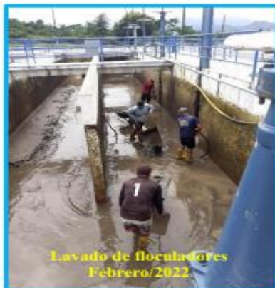
Limpieza y lavado de los floculadores de la planta de tratamiento de agua potable.
