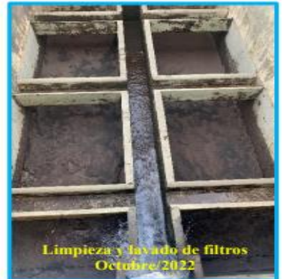
Limpieza y lavado de los floculadores de la planta de tratamiento de agua potable.
