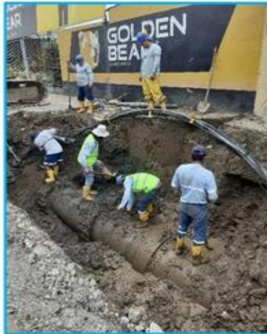
Descubrimiento manual del tubo de asbesto cemento de 800mm en el punto de la fuga.
