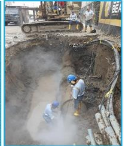
Corte con amoladora del tubo de asbesto cemento en el punto de la fuga.
