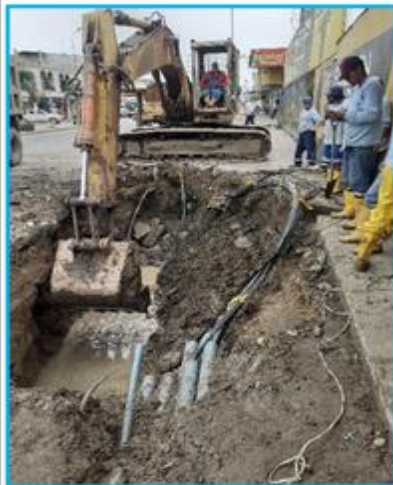
Excavación para descubrir el tubo de asbesto cemento de 800mm averiado; protección de la cablería de fibra óptica.
