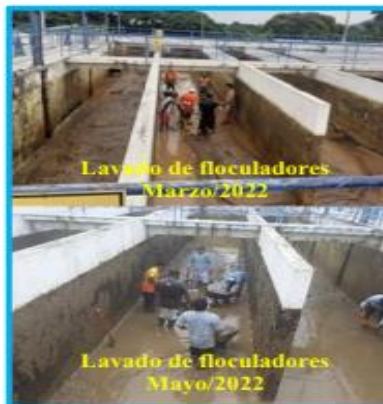
Limpieza y lavado de los floculadores de la planta de tratamiento de agua potable.
