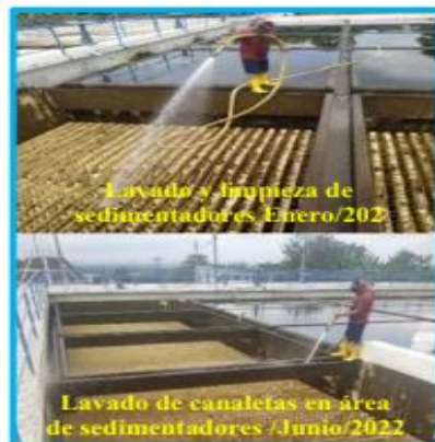
Limpieza y lavado de los floculadores de la planta de tratamiento de agua potable.
